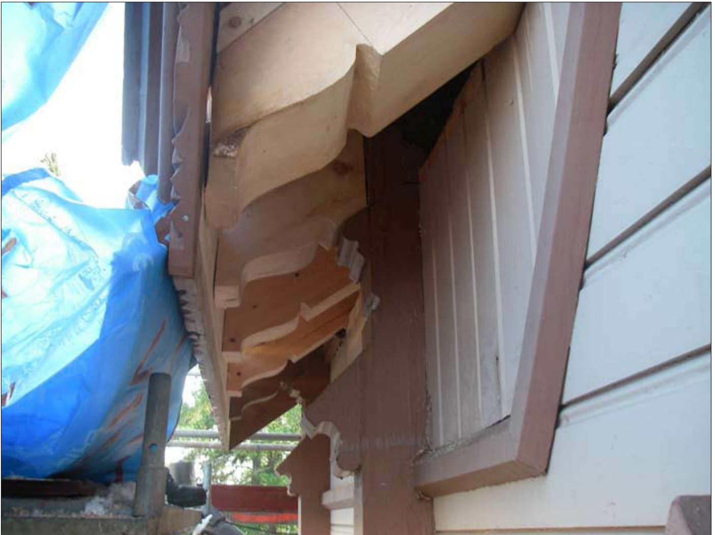
Uusitut kattotuolin päät maalataan ulkomaalauksen yhteydessä.
