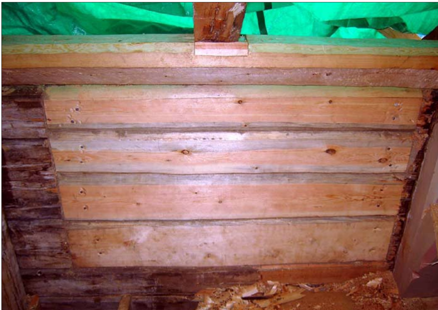
P-A-lohkon vesikattoa myöten uusittu hirsiseinä. Lapaliitokset on kiinnitetty naulaamalla.
