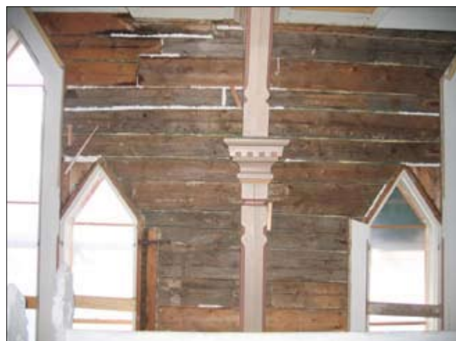
Lohkojen C ja D välinen alue enne ja jälkeen puukuitueristeellä tiklitsemisen (kuvat alla).
