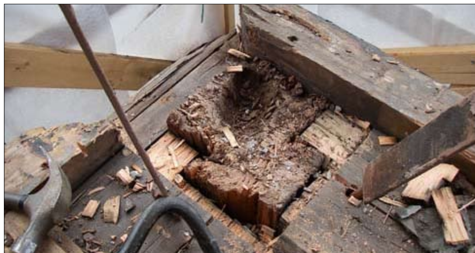
Korjaustyön aluksi eteläkulman pilarin alta piti etsiä kovaa puuta. Pilari oli edellisen kerran korjattu Plastic Padding -massalla.
