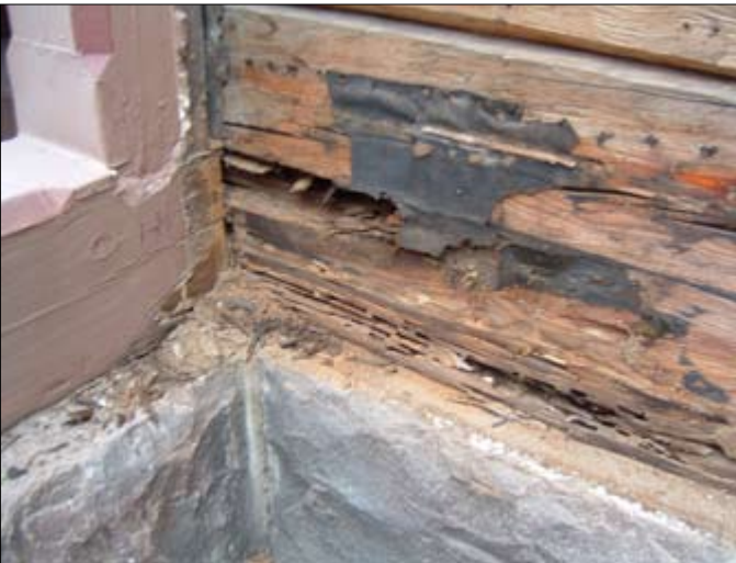
Kaakkoiseteisen ulkoseinän alaosassa laho- ja hyönteisvaurioita.
