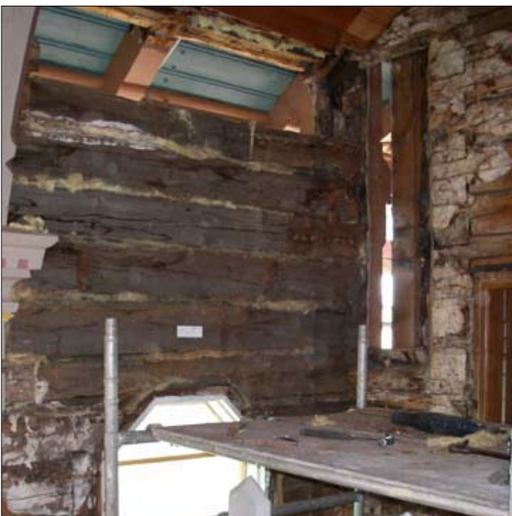
Näkymä korjatusta eteläseinän yläosasta (Kuvassa lohkot vasemmalta oikealle: E-C, E-B ja E-A)
