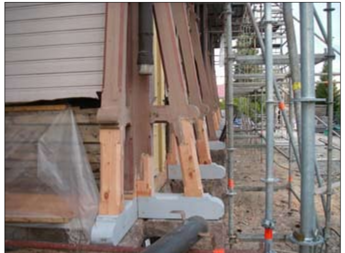
Yhdessäkään pilasterissa ei selviydytty ilman toimenpiteitä.
