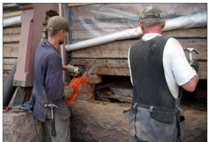
Juha Jaakonaho ja Erkki Hiltunen poistivat puoliksi lahonneet hirret. Syy näkyy vasemmalta alhaalla olevasta kuvassa.
