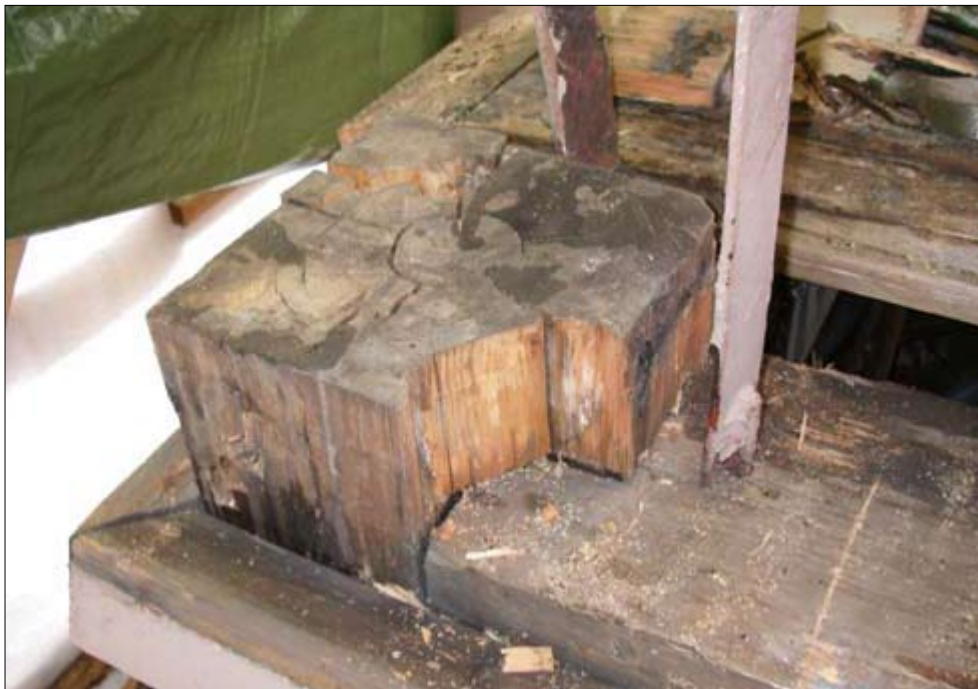
Pohjoiskulman pilarin tynkä oli pehmentynyt ja se jouduttiin lyhentämään ennen uuden asennusta.
