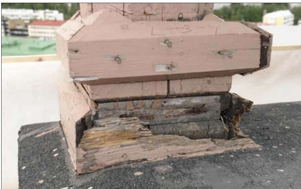
Länsinurkan pilarin verhousen alta paljastui vaurioitumaton alkuperäinen pilari.
