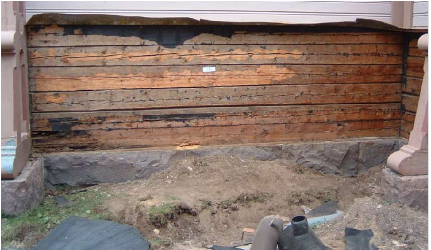
Kaakkoiseteisen ulkoseinän alaosassa laho- ja hyönteisvaurioita.
