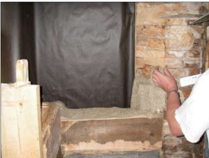
Yläkuvassa olevan nurkan tekovaiheita. Saumat tilkittiin pellavariiveellä.
