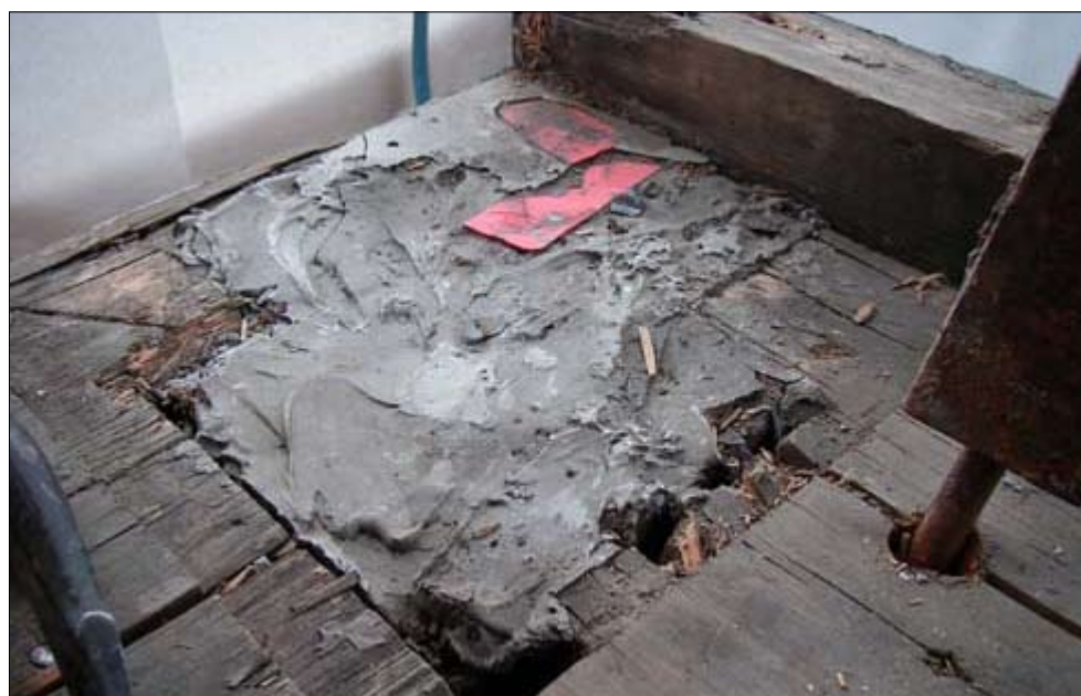
Korjaustyön aluksi eteläkulman pilarin alta piti etsiä kovaa puuta. Pilari oli edellisen kerran korjattu Plastic Padding -massalla.
