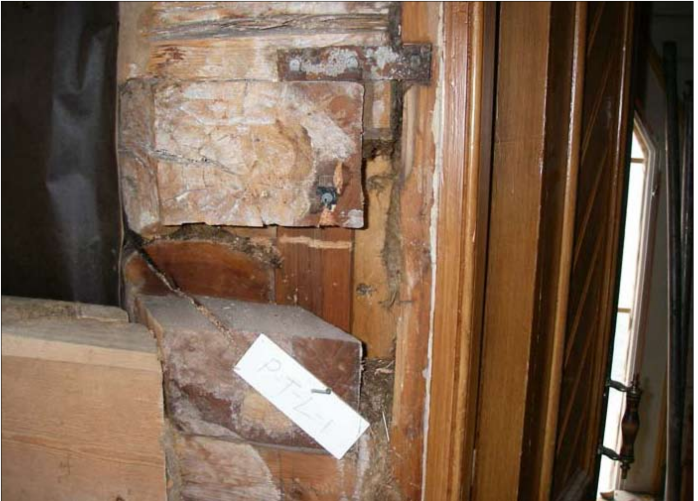
Vinokulmainen liitos oven pielessä. Vanhaan seinään kiinnitettiin kararima. Lisäksi osa uusista hirsistä pujotettiin vanhan salvoksen sisässä olevaan lukkoliitokseen ja kiilattiin puukappaleella yhteen.
